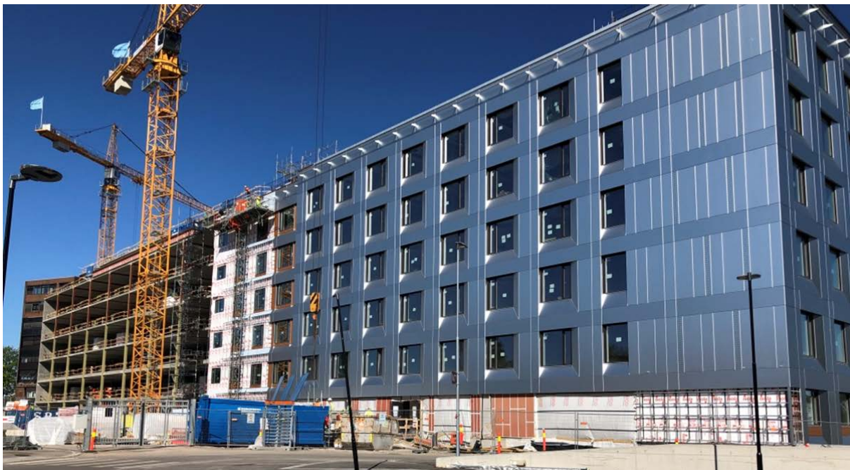
Bilde 2: Fra byggeplass for planlagt nybygg somatikk, Tønsbergprosjektet, Sykehuset i Vestfold HF
