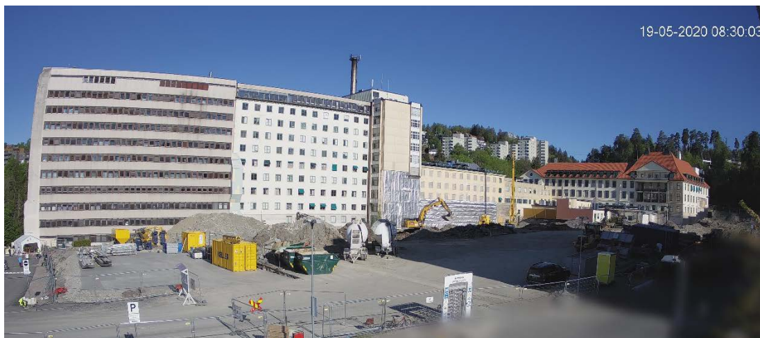
Bilde 3: Bildet viser bygging ved Radiumhospitalet mai 2020, Oslo universitetssykehus HF
