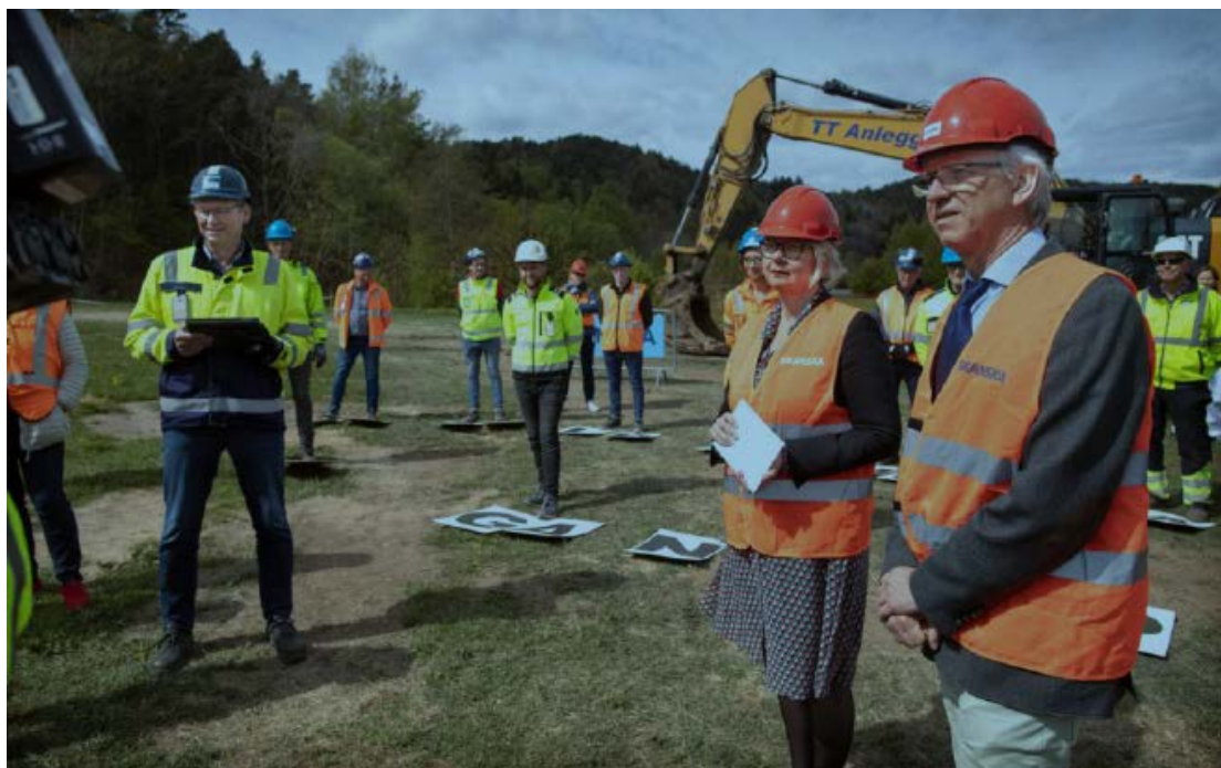
Bilde 4: Avisoppslag i Fedrelandsvennen avis. Klinikkdirktør for psykisk helsevern, Oddvar Sæther (t.h.) og administrerende direktør Nina Mevold under markeringen av byggstart for Nybygg psykisk helsevern Kristiansand, Sørlandet sykehus HF. FOTO: KJARTAN BJELLAND
