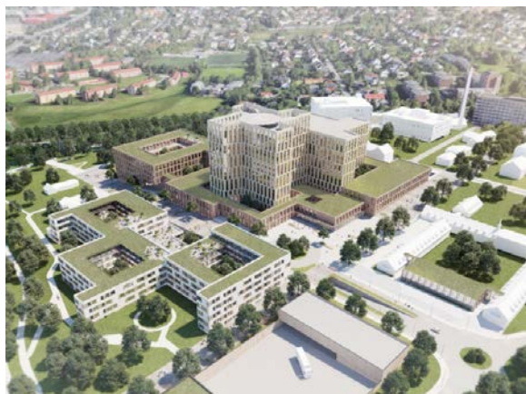
Bilde 6: Illustrasjon nytt sykehus på Aker, Oslo universitetssykehus HF
